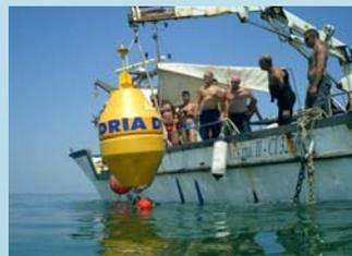
Fig. 4. Operazione di posa di una boa di ormeggio.
